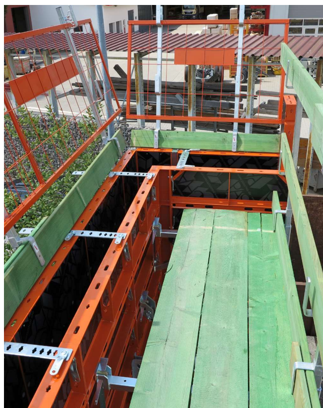
Zubehörteile und Verbindungsmittel der Universalschalung Raster/GE und der LOGO.3 können ebenfalls für die NeoR-Schalung verwendet werden.
