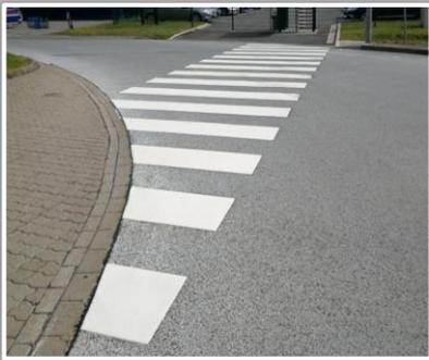
Fertige Straßen- und Parkplatzmarkierung aus Thermoplastik. Das Material wird mit einem Gasbrenner einfach auf den Asphalt oder das Pflaster aufgebracht.
